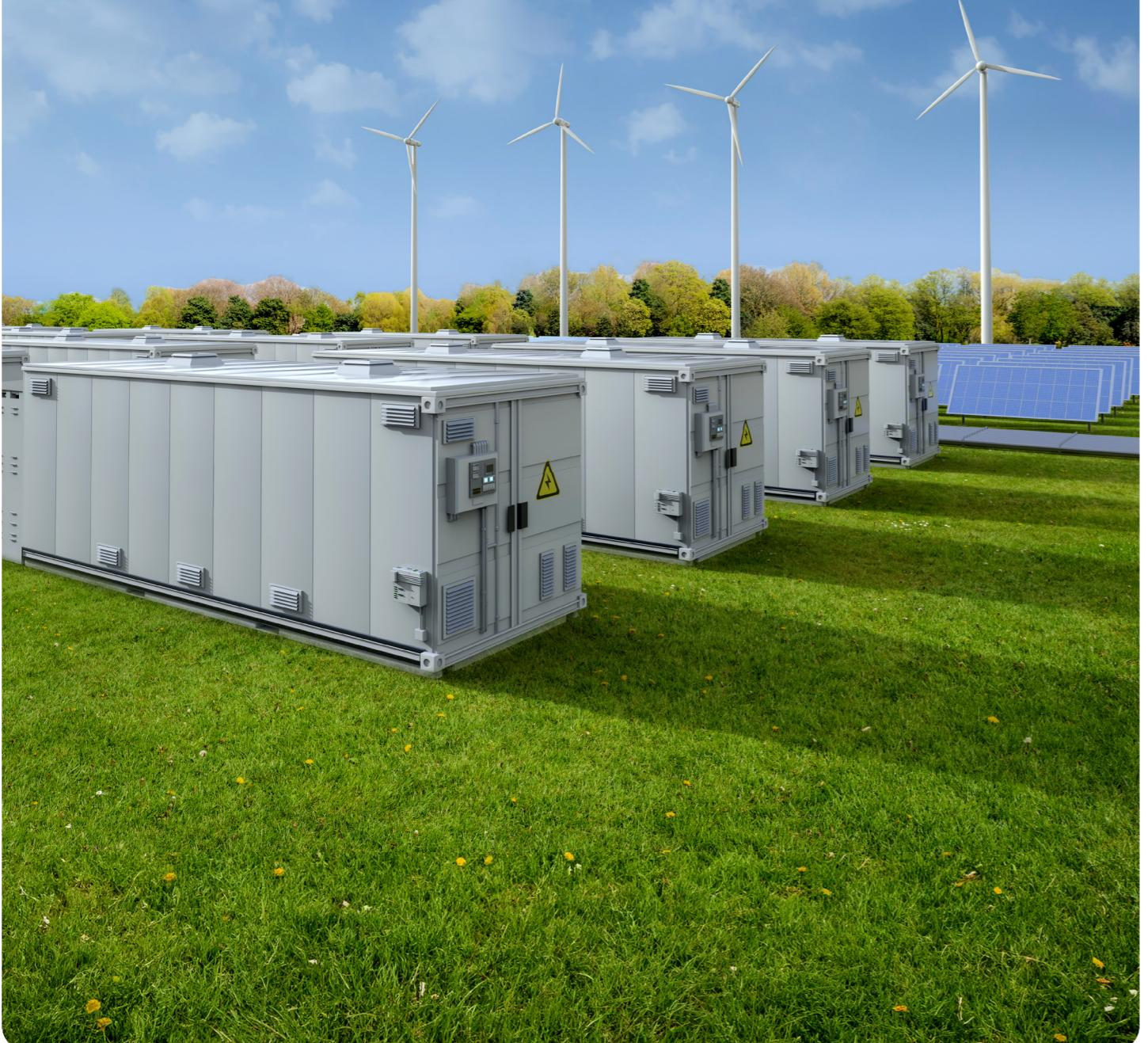
Los Sistemas de Almacenamiento de Energía con Baterías (BESS) están transformando la gestión energética al permitir almacenar el excedente de electricidad y suministrarlo cuando se necesita, desempeñando un papel clave en la **estabilidad y flexibilidad de las redes eléctricas**. Su integración con fuentes renovables como la energía solar y eólica resulta esencial para avanzar hacia un sistema energético más eficiente y sostenible.
