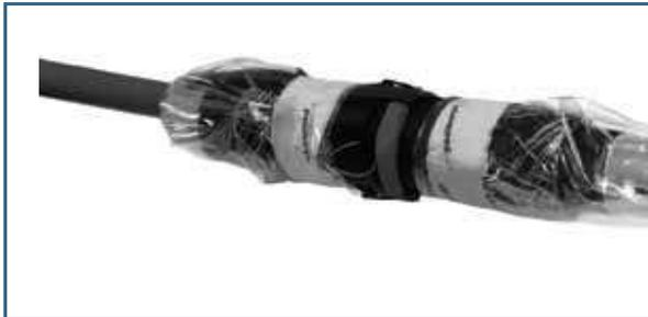
Se realizan cortes para la extracción de la cubierta exterior dejando una distancia para la conexión de la pantalla de hilos de cable y se extrae la capa semiconductor (con especial cuidado de no afectar al aislamiento) para posteriormente hacer la conexión de los conductores. Una vez hecha la unión de los conductores, centramos el empalme sobre el manguito.
