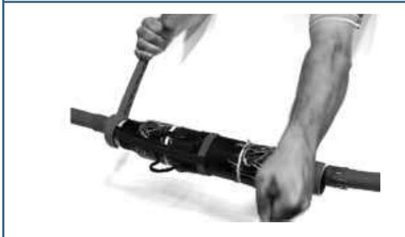
Por medio de las dos palancas suministradas rompemos el tubo de soporte realizando un movimiento de torsión sobre el empalme. Posteriormente se cortan las gomas que mantienen sujeta la pantalla y mediante los anillos metálicos de presión constante suministrados realizaremos la operación de conexión de las pantallas. Sobre los cables previamente preparados aplicamos las placas de sellado de goma vulcanizable.
