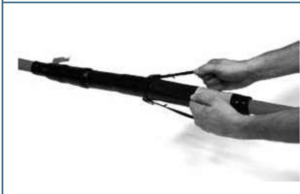
Finalizaremos el montaje del empalme desdoblando las cubiertas, estirando de las cintas de goma incorporadas en el propio empalme.
